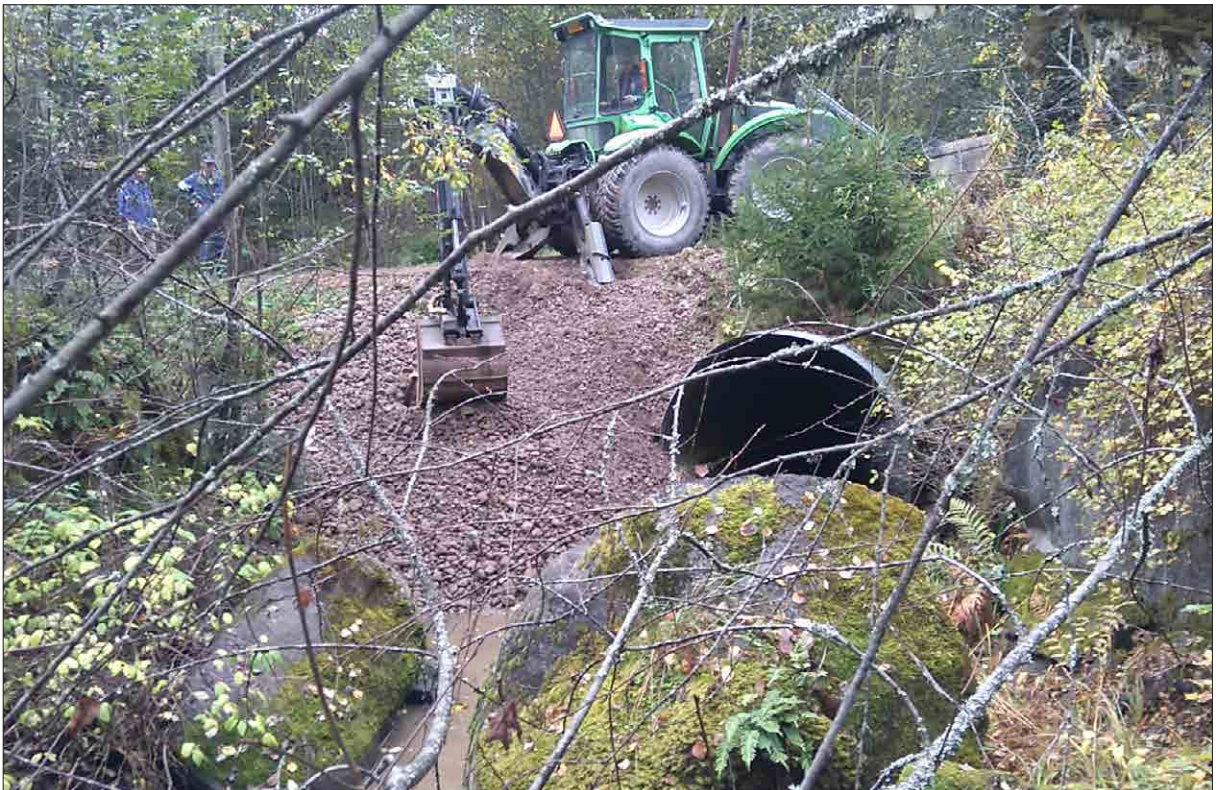
Kuva 28. Rapuojan Paapionkoskelle tuotiin lisäsoraa. Sora kipattiin ja työnnettiin penkalle kosken yläosassa ja nostettiin sitten kaivinkoneella virran kuljettavaksi alemmaksi koskeen.
