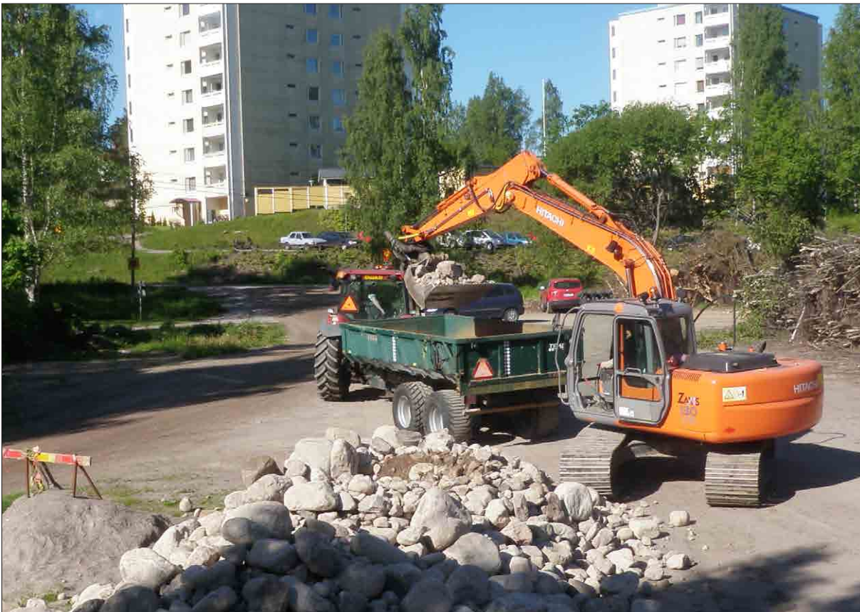
Kuva 20. Kunnostuksessa tarvittava kiviaines tuotiin ensin rekka-autoilla ja lastattiin sitten traktorin peräkärriin maastoon viemistä varten.
