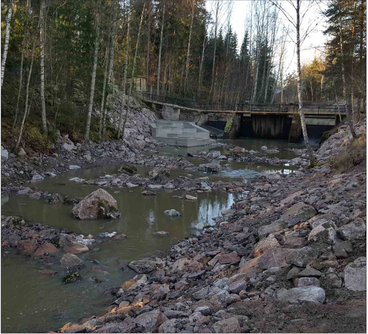
Kuva 39. Ilolanjoen keskijuoksulle Kankurinmäen padon yhteyteen valmistui kalatie syksyllä 2015. Kalatien toteutti Uudenmaan ELY-keskus ja se muodostuu alaosalla luonnonmukaisesta koskesta ja yläosassa nk. teknisestä rakovirtauskalatiestä. (kuva: Harri Aulaskari).
