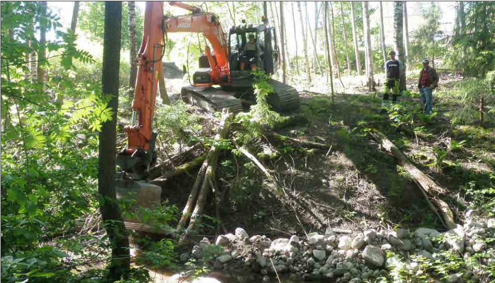
Kuva 7. Gammelbackanpuron kalataloudellista kunnostamista kiviinkoneella kesäkuussa 2015.
