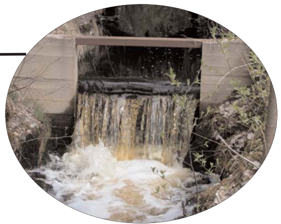
Kuvat 118 ja 119, toukokuu 2003. Lukontien sivussa puro toimii maantien ojana. Oja on enimmäkseen kalliopohjainen. Ojaa tulee kivetä, soraistaa ja betonipadon muodostama este tulee poistaa.
