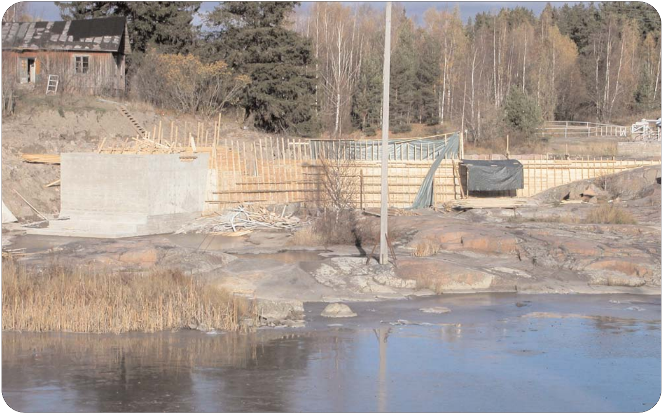
Kuva 20, lokakuu 2003. Tyysterinkosken eteläänpäin laskevaan uomaan, jossa myllytkin ovat aikoinaan sijainneet, on rakenteilla uusi voimala.
