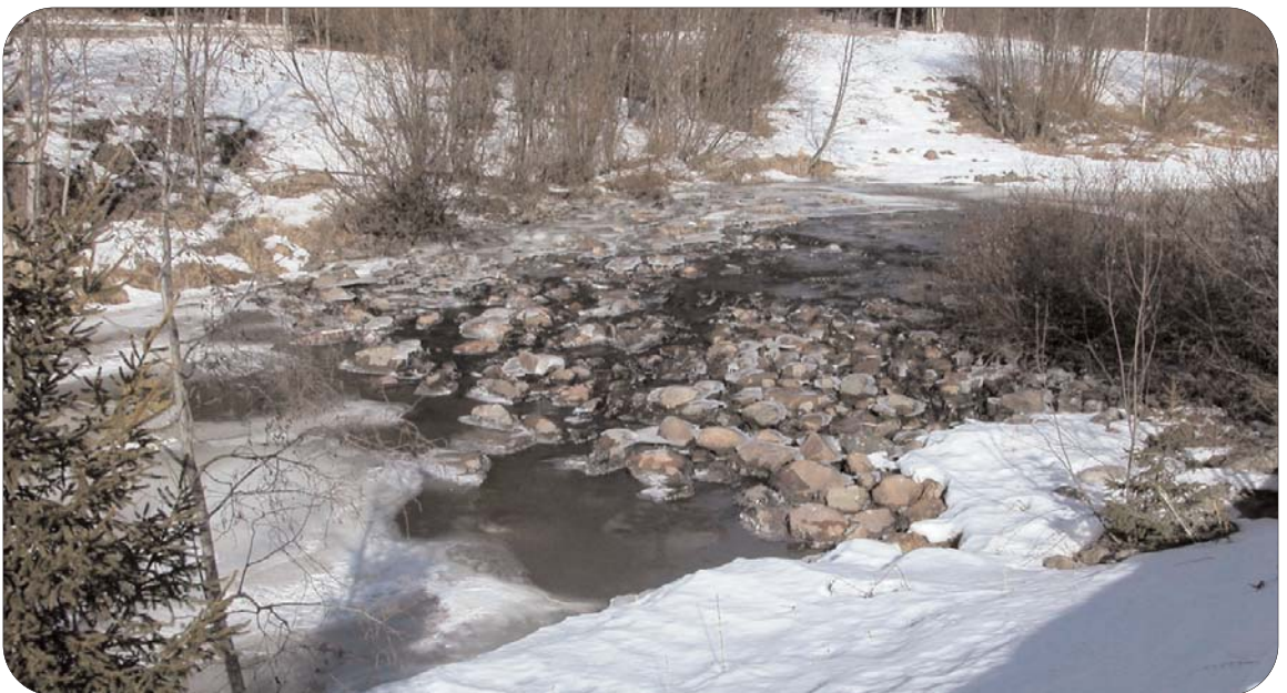
Kuva 122, maaliskuu 2003. Mustijoen latvoilta kosket on perattu kokonaan pois ja vedenpinta pidetään siedettävällä tasolla pohjapatojen avulla. Virtavesien kaloille pohjapatojen tekokosket ovat ympäristöltään aivan liian yksipuolisia ja pinta-alaltaan vähäisiä. Kuvassa on Jokimäen pohjapato.
