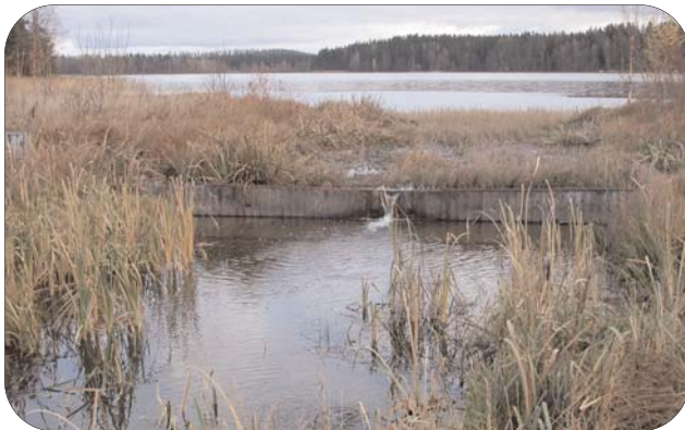
Kuva 100, lokakuu 2003. Kilpijärven luusuan pato.
