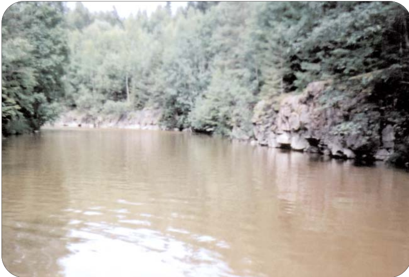
Kuva 123, elokuu 2002. Mustijoen latvoilla on perkausten yhteydessä tehty mittavia kalliroleikkauksia. Koskien entistäminen ei enää ole mahdollista. Nykyiset pohjapadot tulee kunnostaa luonnonmukaisiksi tekokoskiksi, jotka vastaavat virtavesieliöstön elinympäristövaatimuksia. Kuva on Kirinkosken alapuolelta.
