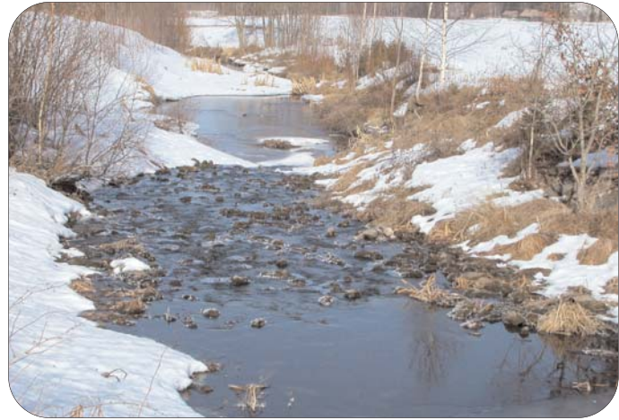
Kuva 70, maaliskuu 2003. Monsolantien alapuolella sijaitseva pohjapato on loiva.
