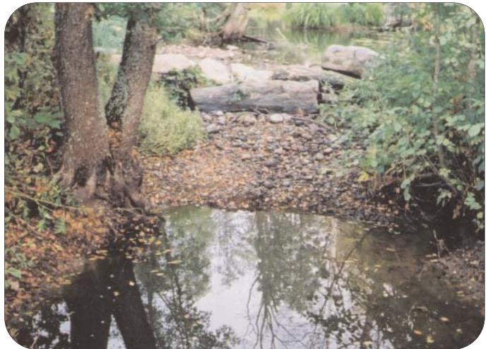
Kuva 82, elokuu 2002. Edellisen padon yläpuolella on pohjakynnys, joka tulee muokata luonnonmukaisemmaksi.
