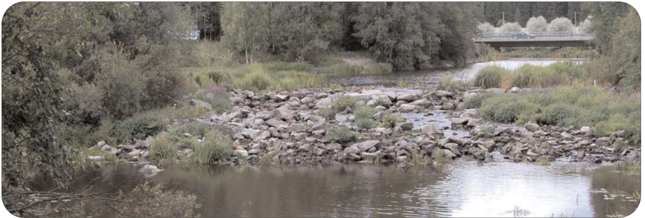
Kuva 64, elokuu 2003. Pohjapadoksi muutettu Hurankoski.
