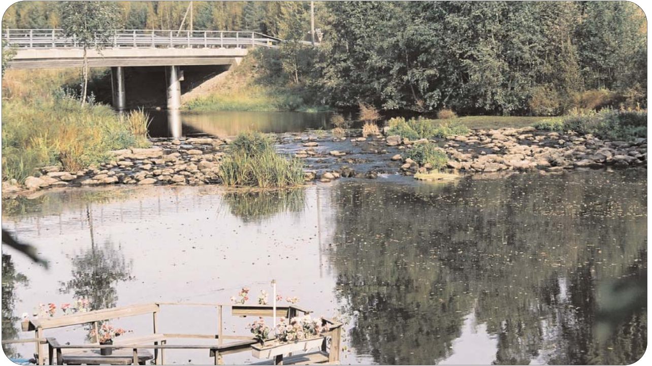
Kuva 68, syyskuu 2002. Kalkinkoski on muutettu lyhyeksi pohjapadoksi.
