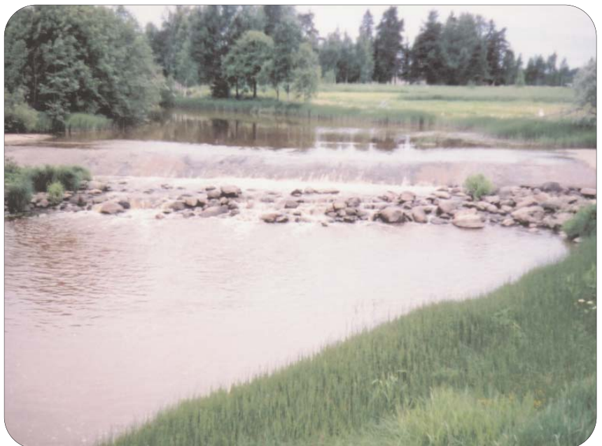
Kuva 67, elokuu 2002. Lontoon pohjapadossa on pitkä betoniluiska, joka toimii tehokkaana vaellusesteenä.
