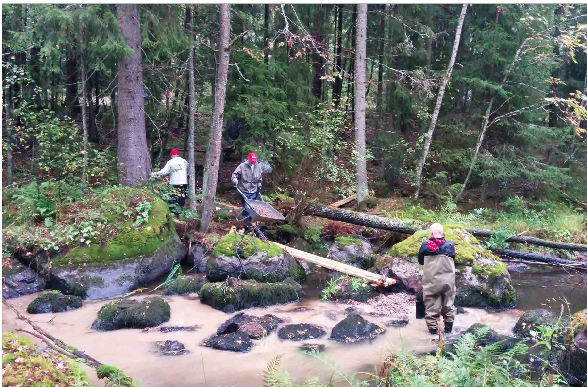
Kuvat 48 ja 49. Ilolanjoen Vadbäckeniin Porvoossa kunnostettiin kutusoraikkoja. Soran vieni puroalle on ollut maaston vuoksi ongelma, joka ratkesi betoniauton hihnan avulla. Talkooväki toteutti lopullisen soran siirron ja kutusoraikkojen kunnostuksen.
