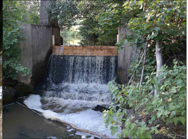
Kuvat 45 ja 46. Ilolanjoen Postimäenkoskeen palautettiin patoaukossa olleet settilankut. Lankkujen avulla ohjattiin veden virtausta kahteen luonnontilaisempaan sivu-uomaan, joita pitkin vaelluskalan on helpompi nousta.
