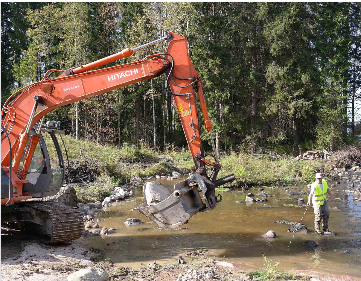
Kuva 38. Kunnostustyötä Myllykulmankosken sivuuomassa.
