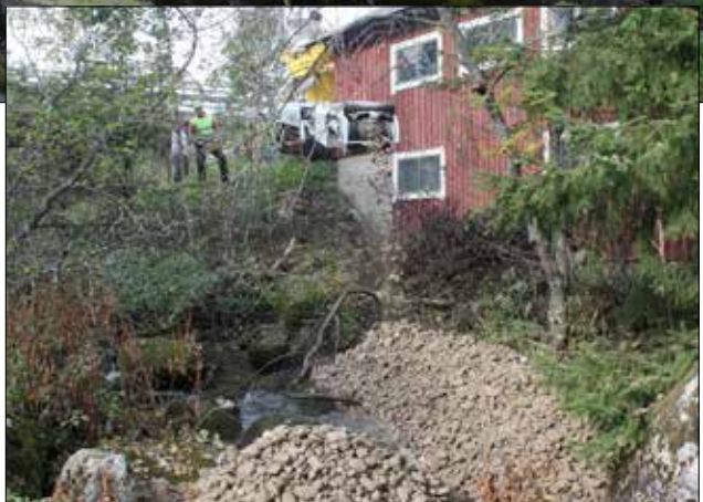
Kuvat 34 ja 35. Hollolan Hahmajoella kutusora hihnattiin betoniautolla koskeen.
