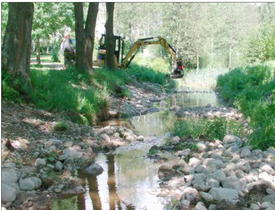
Kuvat 7 ja 8. Yläkuvassa kartta Jokitalkkarihankkeen kunnostuskohteista. Vasemmalla kunnostusta kiveämällä ja so- raistamalla Porvoon Gammelbackanpurolla kesäkuussa 2014.
