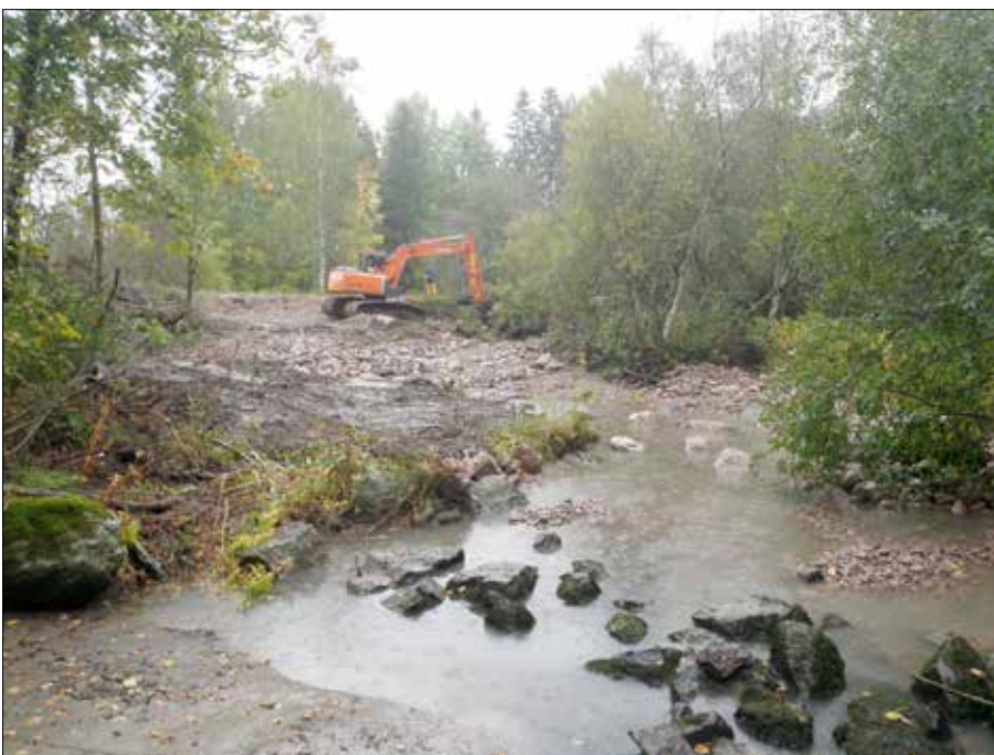
Kuva 54. Kunnostettu alue on noin 50 metriä pitkä ja kunnostamiseen käytettiin kuusi kuorma-auton lavallista kiveä ja soraa.
