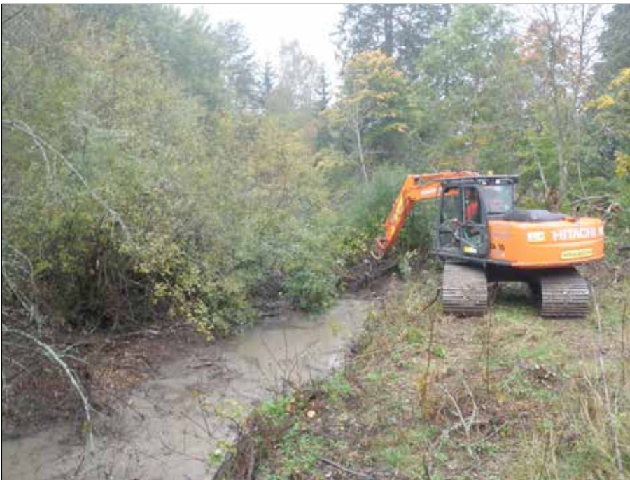
Kuva 53. Virmajoen kunnostusalue Aleksinmäessä on osittain kovapohjainen puro-osuus vanhan patoraunion alapuolella. Rannan tulvakaistalle piti aluksi raivata kulku-ura töitä varten.
