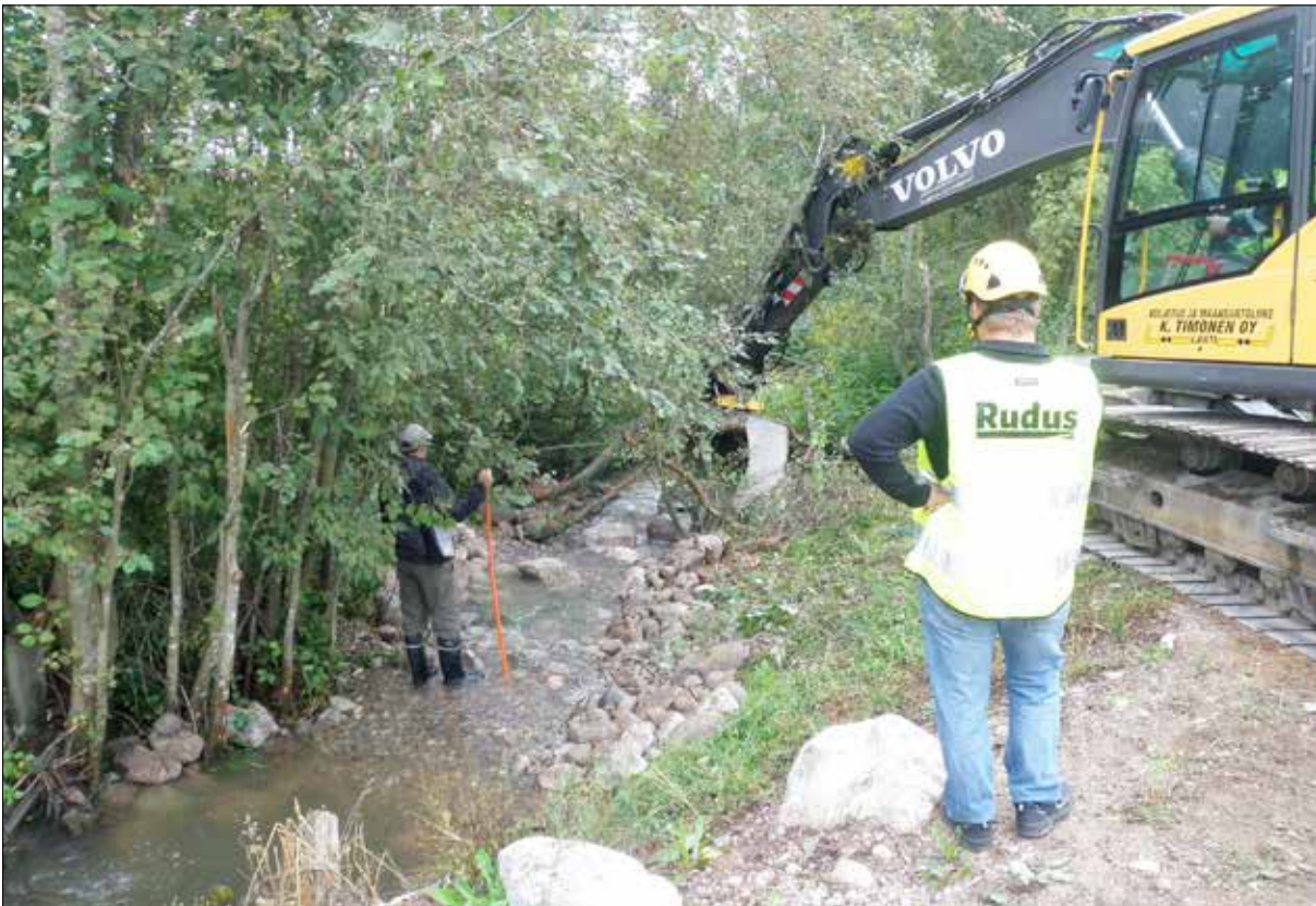
Kuva 27. Porvoonjoen vesistöön kuuluvan Erviänojan kunnostus toteutettiin pääosin kaivinkonetyönä.
