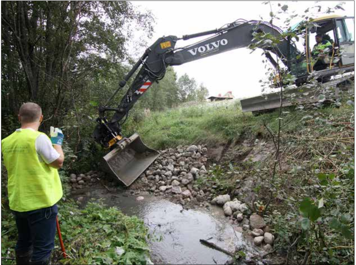
Kuva 30. Pellon reunan sortumia tuettiin kiveyksin.
