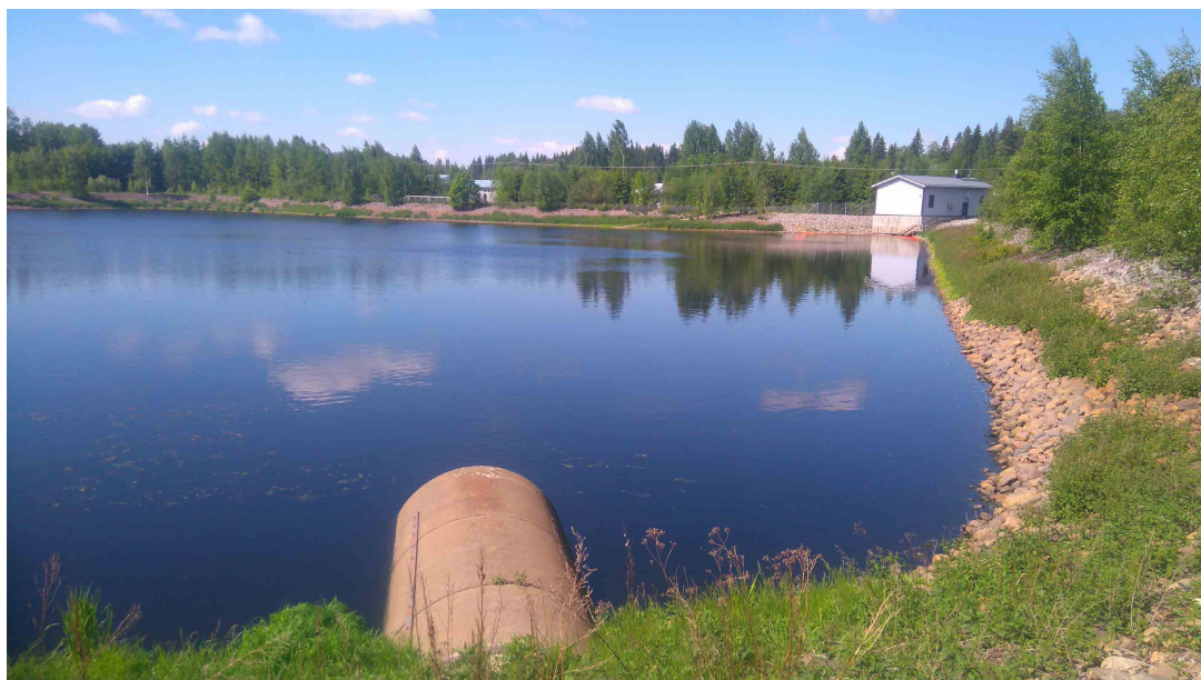
Kuva 1. Lahden Kariniemen ja Ali-Juhakkalan jätevedenpuhdistamoiden tasausallas ja UV-hygienisointilaitos kuvan oikeassa alakulmassa.
