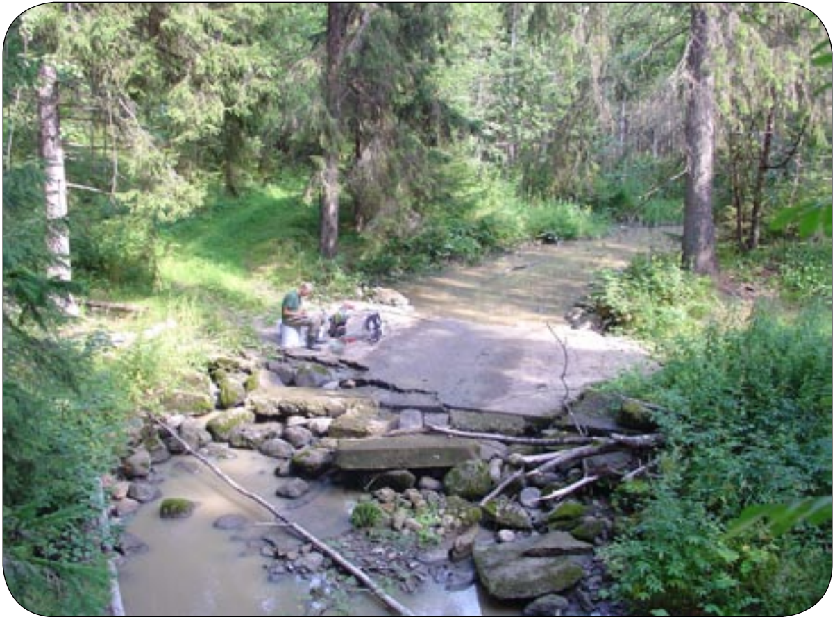
Kuva 11. Rakunäsin koskialueen poikki on rakennettu silta, jonka betonikansi makaa kosken kivien päällä. Pienillä virtaamilla vesi mahtuu virtaamaan kivikon läpi, mutta suuremmilla virtaamilla silta jää veden alle. Pienet kalat mahtuvat ilmeisesti uimaan kivien väleistä, mutta suuremmilta kaloilta silta voi ajoittain katkaista kulkuyhteyden. (Kuva S.V.)
