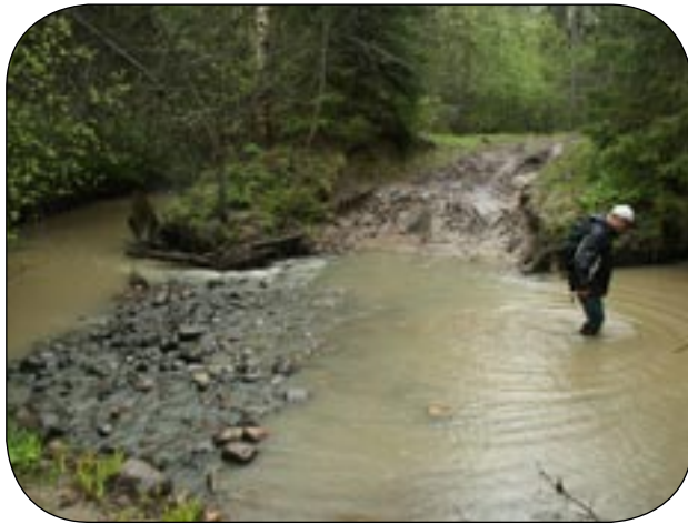
Kuva 14. Rengaspolunkosken niskan yli on rakennettu kantava kulku-ura traktoria ja ratsastuspolkua varten.
