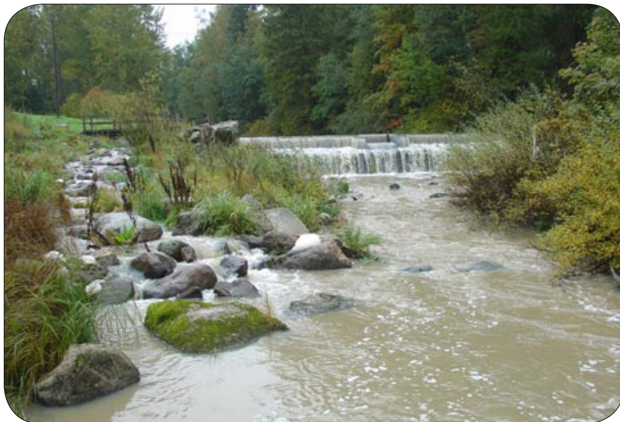
Kuva 22. Brobölen pato muodosti aiemmin vaellusesteen Sipoonjokeen, mutta kuvan vasemmassa reunassa näkyvän kalatien rakentamisen myötä kaloilla on nousumahdollisuus Sipoonjoen yläosan koski-alueille ja sivupuroihin.
