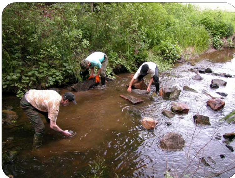
Kuva 9. Perattuihin koskiin kivettiin suojapaikkoja kaloille ja niiden ravintona toimiville monenlaisille vesieliöille. Useimmissa kunnostuskohteissa valtaosa työstä oli käsityötä, jonka tekivät kohteiden paikalliset asukkaat talkoilla. (Kuva Elisa Törmänen)
