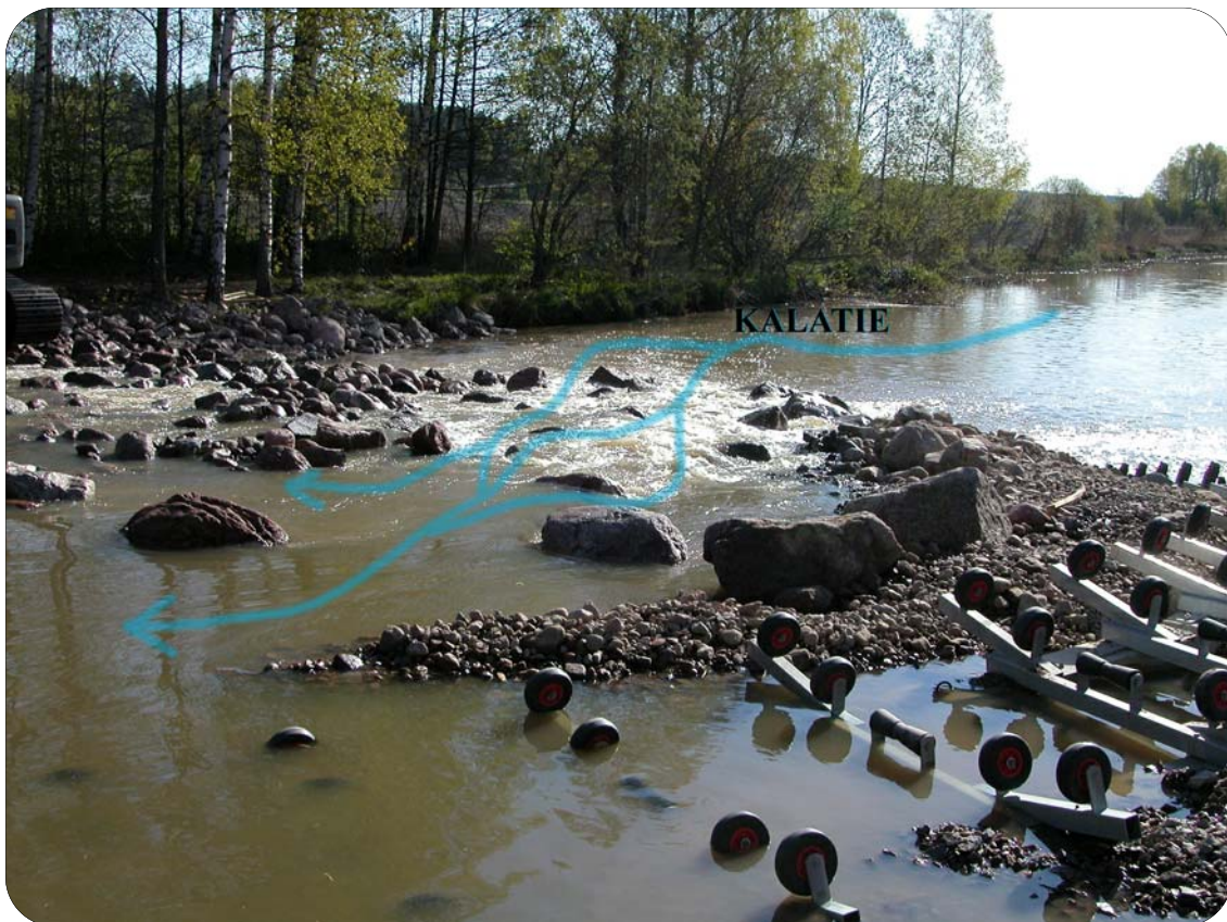
Kuva 132. Ilolanjoen alajuoksulle rakennettiin kesällä 2006 pohjapato, jonka tehtävänä on turvata Porvoon veden käyttämien pohjavesialueiden vesivarastot. Ajoittain meriveden lasku laskee joen ja myös Sannaisten harjun pohjaveden pintaa.
