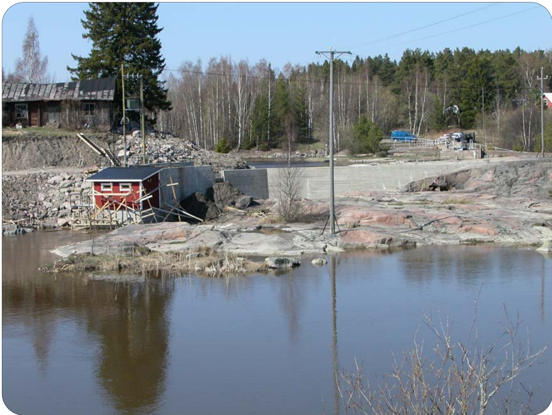
Kuva 122. Tyysterinkosken uuden vesivoimalan rakentamiseen Mustijoen alajuoksulle on liittynyt monenlaisia epäselvyyksiä. Voimalan rakentamista edellyttäviin lupaehtoihin kuului, että koskeen rakennetaan kalatie voimayhtiön kustannuksella ja kalatiehen juoksutetaan tarvittava määrä vettä. Voimalan valmistuttua yhtiö on kieltäytynyt rakentamasta kalatietä ja jos valtio rakentaa kalatien, vaatii voimayhtiö korvausta kalatiehen juoksutettavasta vedestä.
