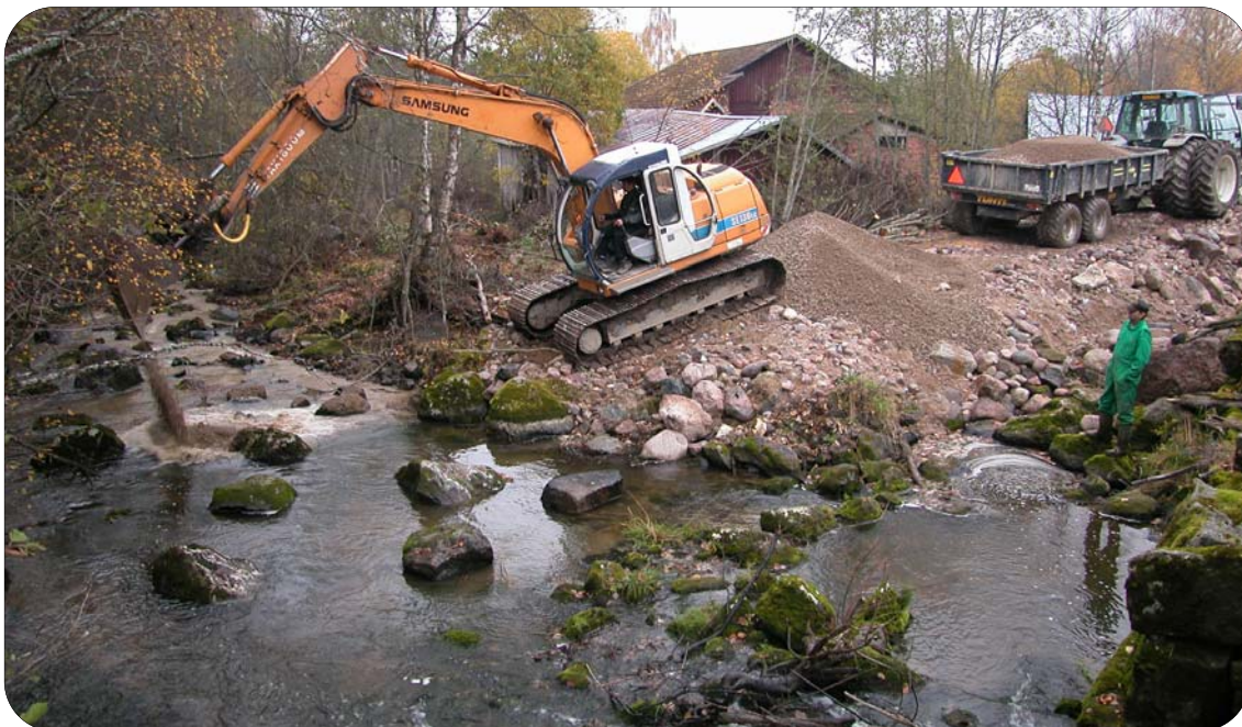
Kuva 74. • Padon ja kalatien alapuolelle nostettiin lisäkiviä ja kunnostettiin kutusoraikkoja.
