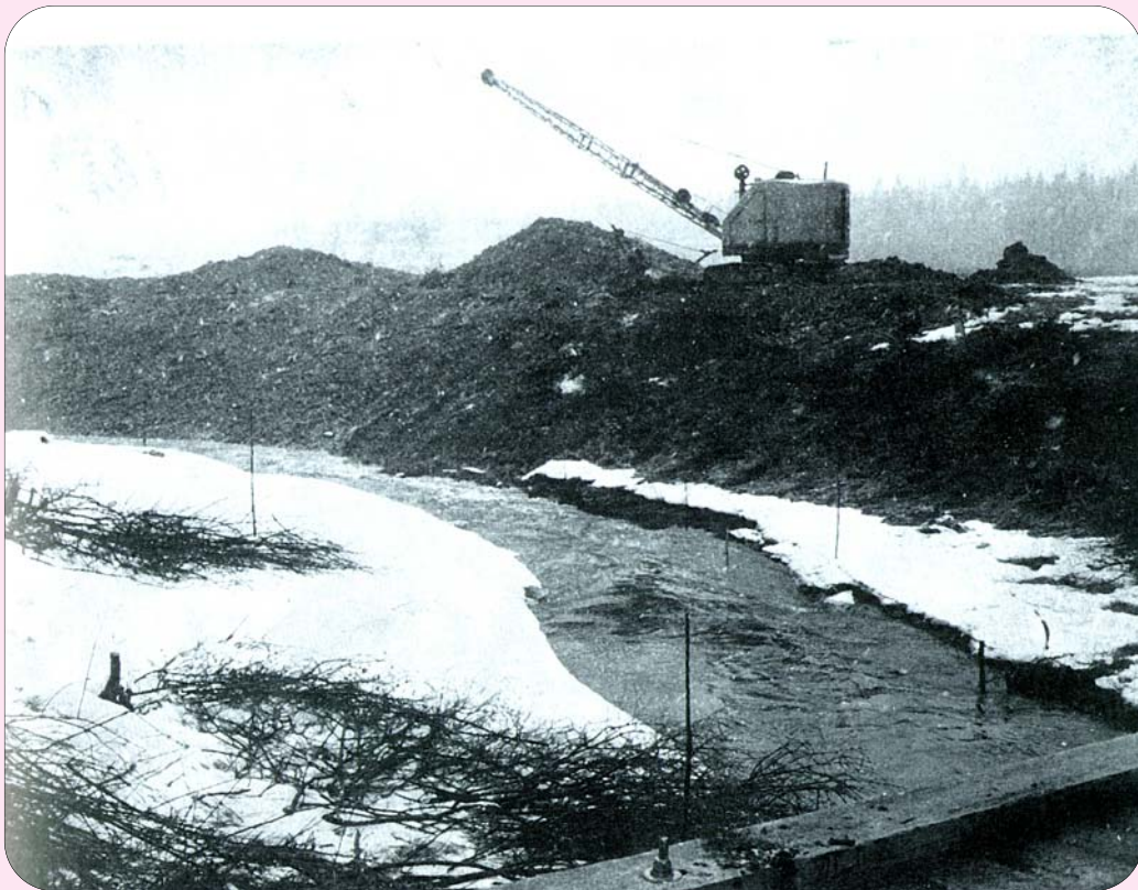
Kuva 33. Mustijoen perkaustyömaa vuonna 1977. (Kuva: Mäntsälän historia III, s. 271.)
