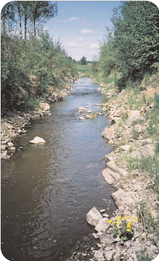
Kuvat 4 ja 5. Joen latvoilla syvään kanjoniin perattua jokiuomaa. Vieressä kuvamanipulaationa toteutettu esimerkki siitä, miltä jokiosuus voisi näyttää kunnostettuna.. Kallioon louhittuun uomaan ei saa luotua mutkittelua, joka muuten olisi suotavaa kunnostettavalle kohteelle (Kts. myös kuva 40.)
