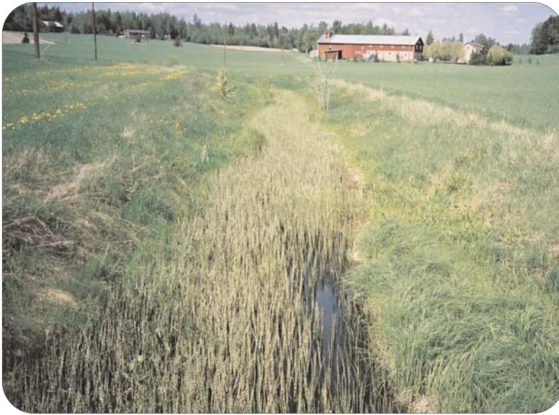
Kuva 64, kesäkuu 2003. Perattu Tankvallinoja. Umpeenkasvulla uoma pyrkii palautumaan luonnontilaiseksi. Kalaston ja vedenlaadun kannalta ongelman muodostaa mahdollinen tarve uudistaa perkaus.
