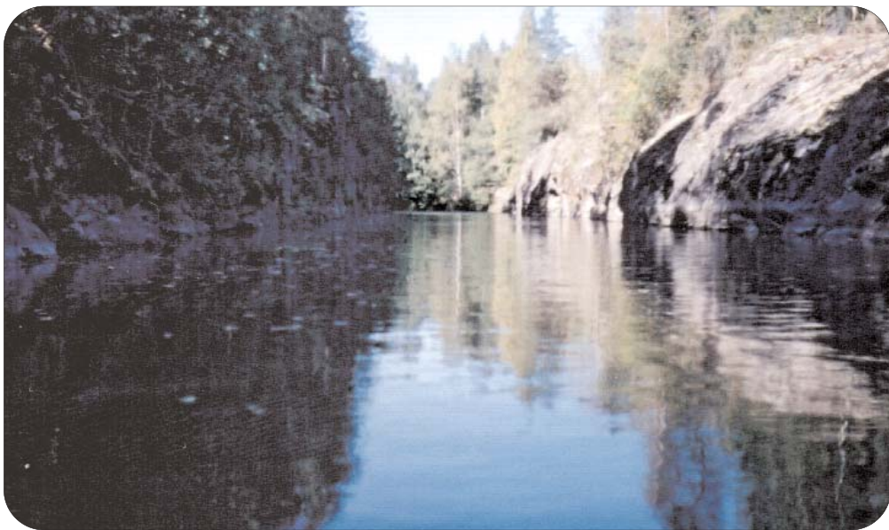
Kuva 67. Kankurinmäen (Vävarsbacka) padon yläpuolella on tehty mittava kallioleikkaus. Kalliota louhittiin jo 1700-luvulla ja kallion ja silloisen kosken yläpuolelta kuivattiin järvi 1800-luvun alussa. Suurin perkausurakka toteutettiin valtion tukemana 1950-luvulla.
