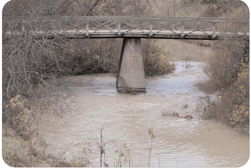
Kuva 12, lokakuu 2002. Klemetintien sillan alla on virtapaikka.
