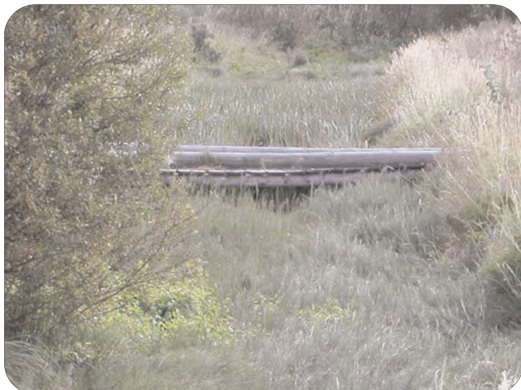
Kuva 36, syyskuu 2003. Hakanurkan yläpuolisella avoimella pellolla leveäksi perattu uoma on kasvanut umpeen.
