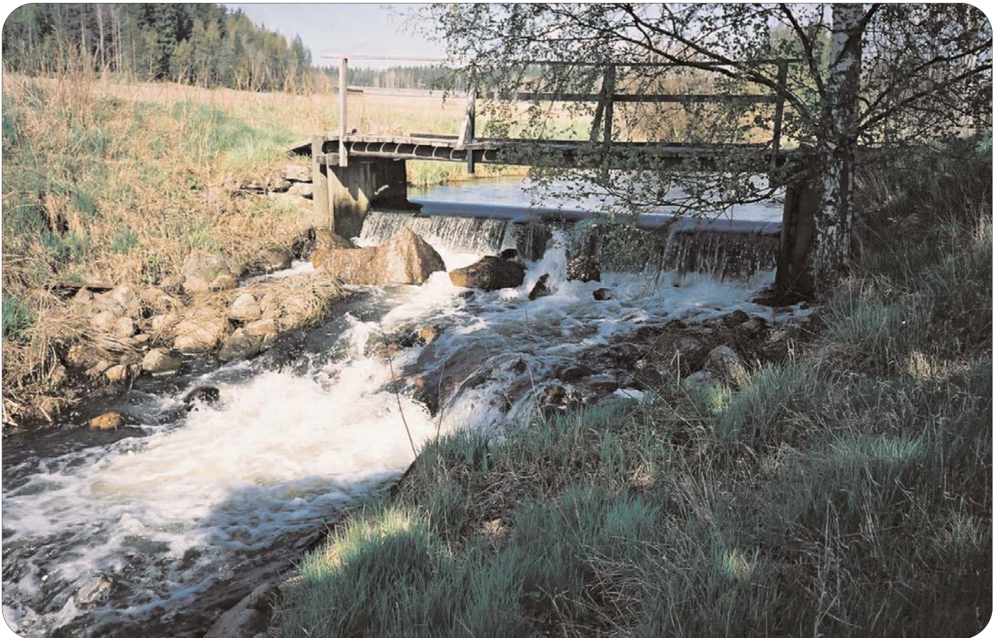
Kuva 55, toukokuu 2003. Kylänpäänjärven alapuolella oleva pato estää kalojen nousun. Padon yläpuolella on laaja vesistö ja padon yhteyteen on rakennettava kalatie tai kalaluiska.
