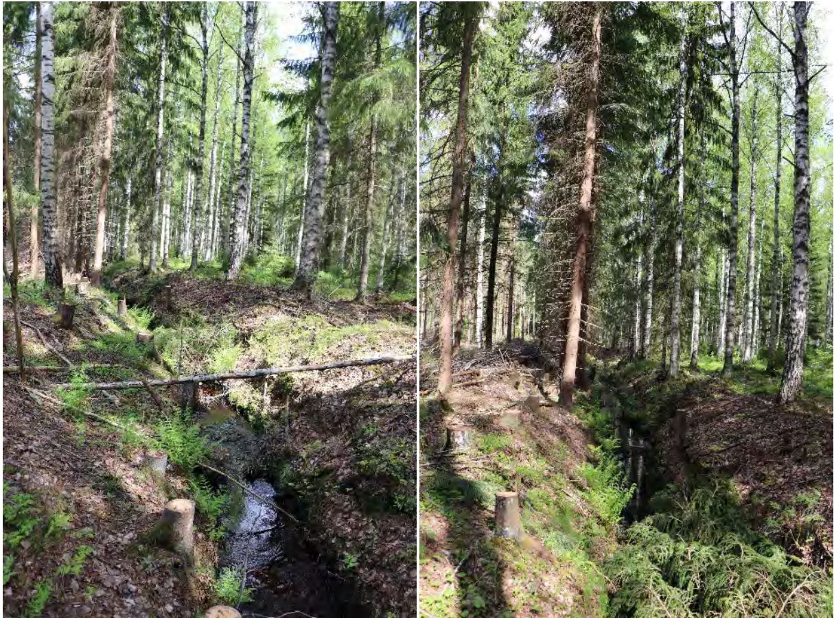
Kuva 32. Havaintopiste 3. Uomaan on muodostunut luonnollisia pohjapatoja, mutta virtausta ja eroosiota voitaisiin vähentää entisestään rakentamalla pohjapatosarja (vrt. havaintopiste 2).
